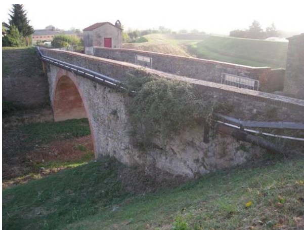
Le tubazioni finora a vista verranno interrare migliorando l'aspetto estetico del ponte
