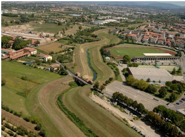
Una veduta aerea dell'area di Lastra a Signa in prossimità del torrente Vingone
