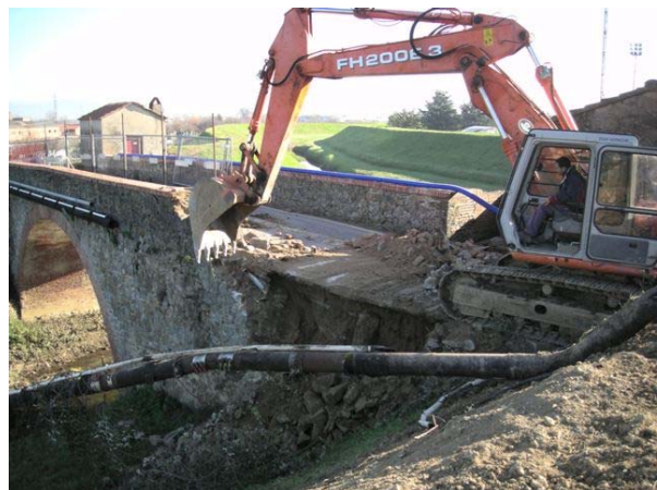
Le lavorazioni alla spalla del Ponte di Via del Piano
