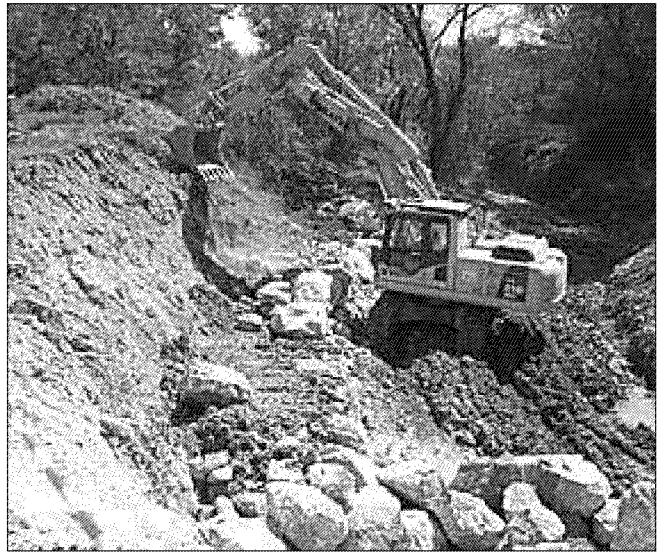
Messa in sicurezza Lavori per rafforzare gli argini
